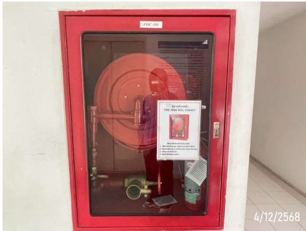
ตู้ดับเพลิง (Fire Hose Cabinet : FHC)
